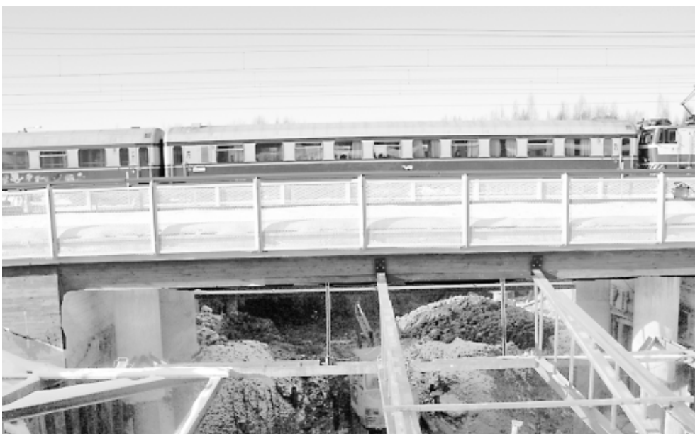
Urpian aseman jalankulkukäytävän kaivuutyö
